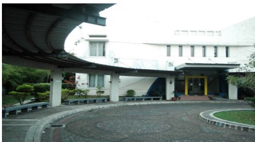
Gambar 2.10 Gedung Sekolah Luar Biasa PUSPPA Suryakanti
