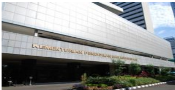
Gambar 2.8 Gedung Kementerian Pendidikan dan Kebudayaan Nasional di Jakarta
